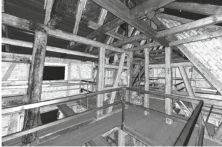
Punktwolke des Scheunendachstuhls
